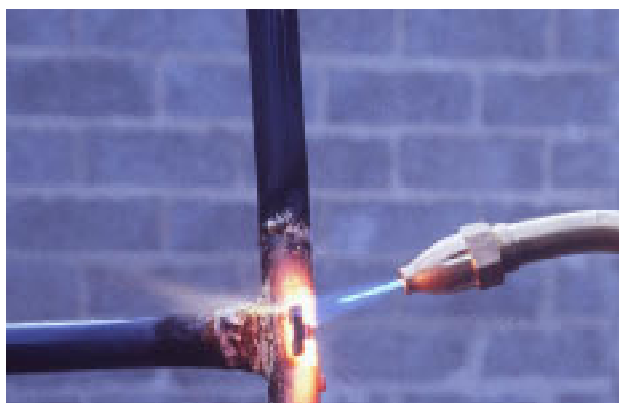
Figuur 4.4 Constructiewerkzaamheden – Gebruik van stille soldeerlamp © Yves Cousson – Met dank aan INRS - Frankrijk
